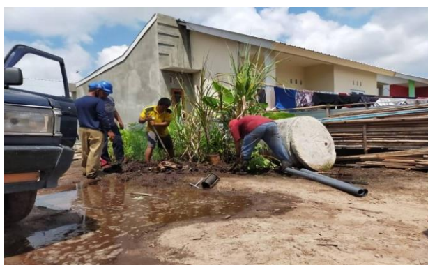
Gambar 1. Proses Penggalian Untuk Menyambungkan Pipa Sambungan Baru (SR)
