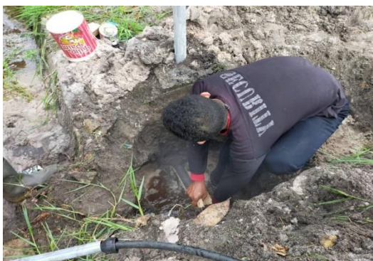
Gambar 2. Proses Penyambungan Sambungan Baru (SR)
