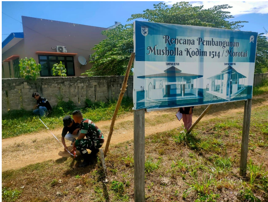
Gambar 1. Survey pengukuran batas-batas rencana bangunan
